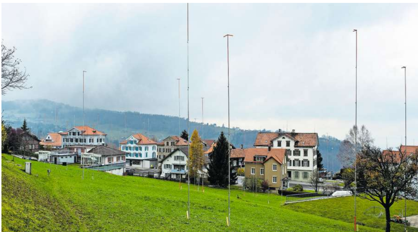
Die Gemeinde Wolfhalden muss zwei Hektaren Bauland auszonieren.
